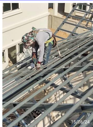
รูปที่ 3-9 คนงานสวมใส่อุปกรณ์ป้องกันอันตราย ส่วนบุคคล
