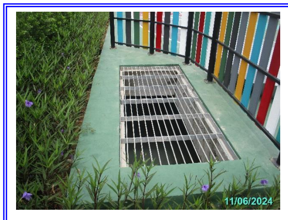
รูปที่ 3-13 ตะแกรงดักขยะ
